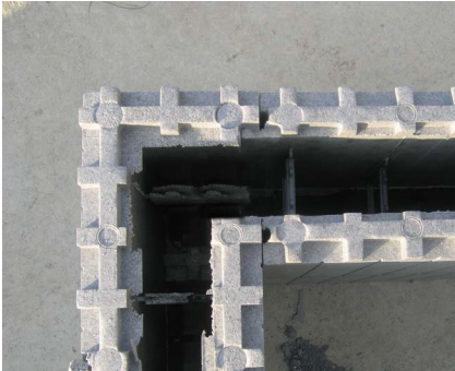
Element MCF 1/15 im Eckwinkel.
